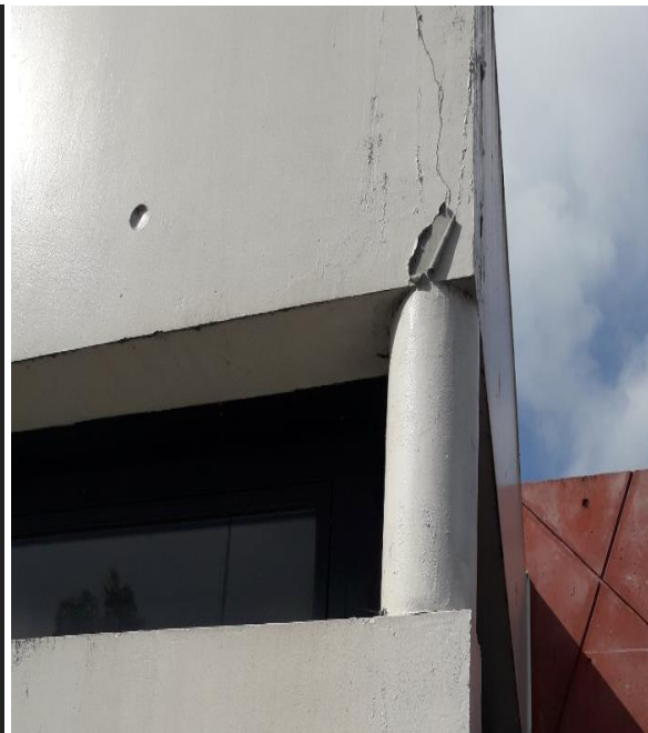
Fig 05 : Fissure d'angle des poutres
