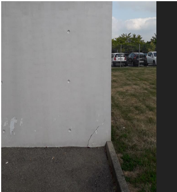
Fig 04 : Fissure en pied de mur
